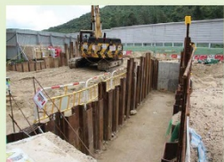
東涌第58區—基建設施的填海工程 Tung Chung Area 58 - infrastructure works in progress
